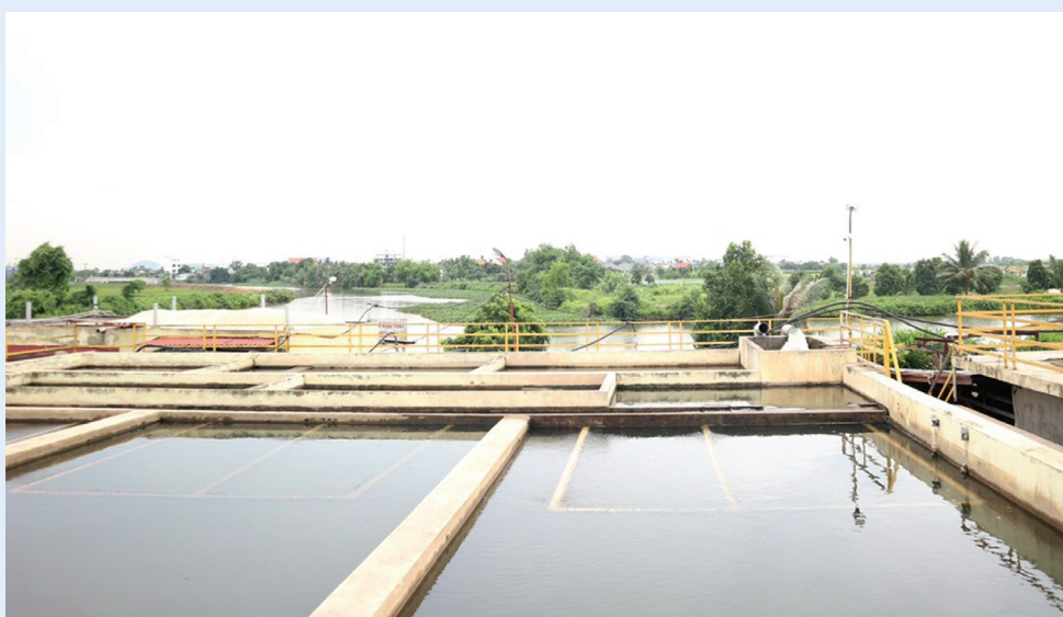
Khu vực xử lý nước của Nhà máy nước Lê Thiện (phường An Phong).
