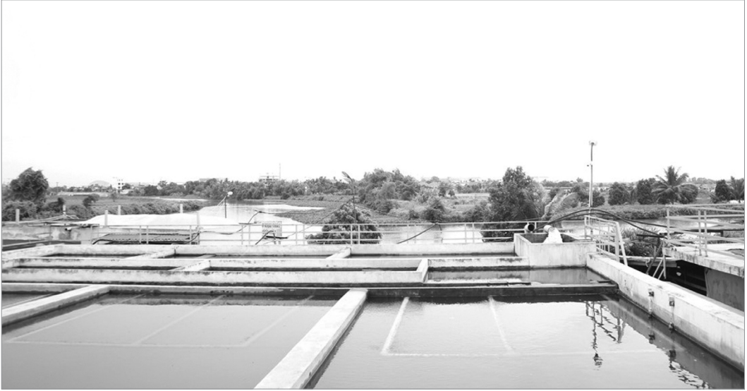
Khu vực xử lý nước của Nhà máy nước Lê Thiện (phường An Phong).
